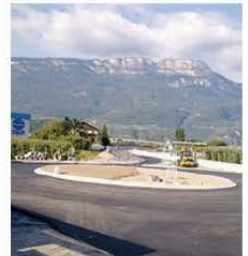
La rotatoria con i lavori in corso
